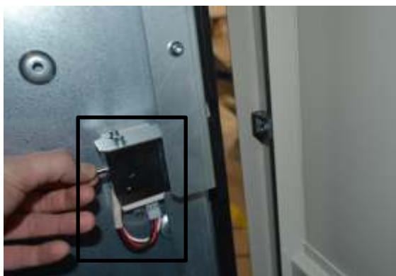
LBSF electromagnetic interlock door
